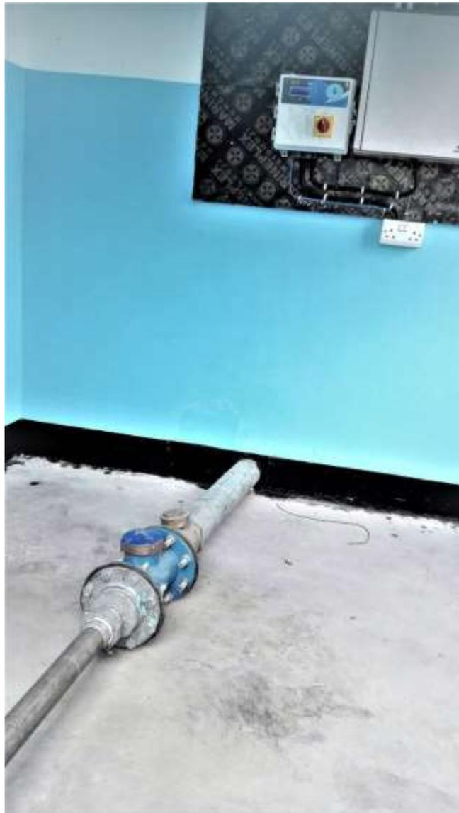
**Einbau eines Wasserzählers durch die Schule für das Wassermanagement. Täglich werden die Werte kontrolliert.**
