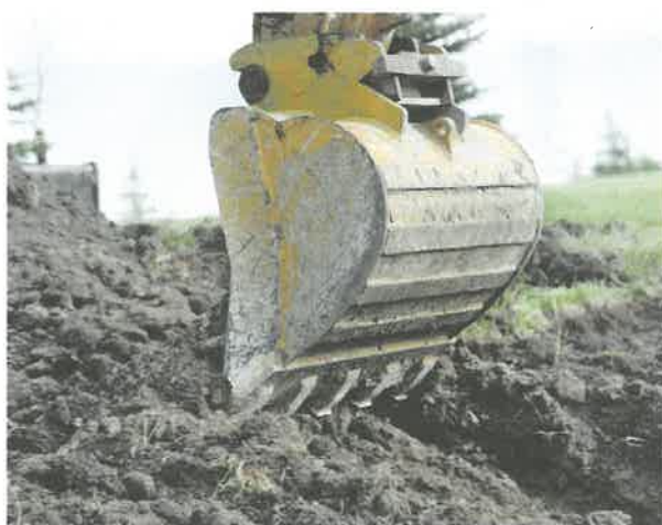
Es braucht in Vorarlberg mehr Deponieflächen.
